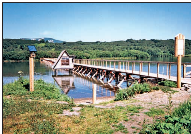
Рис. 43. Новое рыбоучетное заграждение на Озерновском наблюдательном пункте, построенное в июне 1999 г. для подсчета численности нерки, пропущенной в оз. Курильское на нерест (фото Е. А. Шевлякова – слева, А. В. Маслова – справа)
