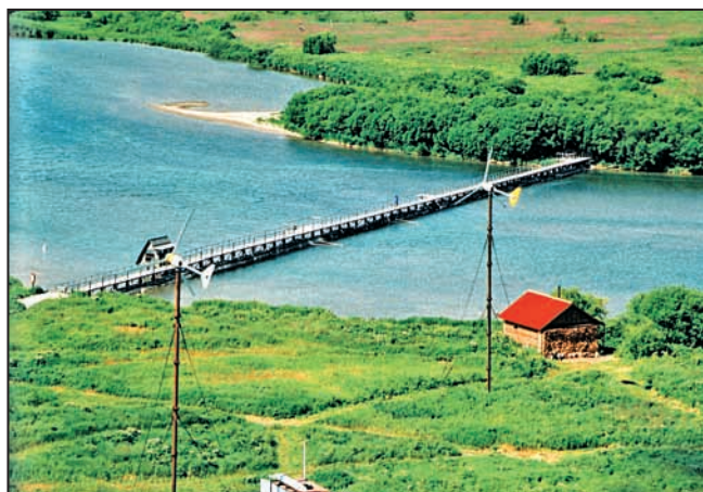
Рис. 43. Новое рыбоучетное заграждение на Озерновском наблюдательном пункте, построенное в июне 1999 г. для подсчета численности нерки, пропущенной в оз. Курильское на нерест (фото Е. А. Шевлякова – слева, А. В. Маслова – справа)
