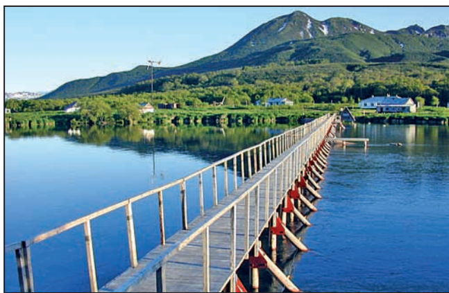
Рис. 44. Озерновский наблюдательный пункт и рыбоучетное заграждение в истоке р. Озерной (июль 2004 г., фото А. В. Маслова)
